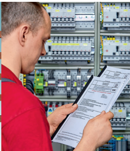
A túlfeszültségvédelem legjobb helye a főelosztóban van.
